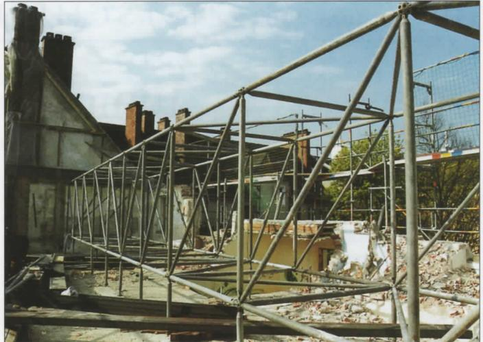
Eine spezielle Stahlkonstruktion sichert die Nachbargebäude beim Abbruch und Neubau des Hauses Schneckenburgerstraße 37 Foto: cws
