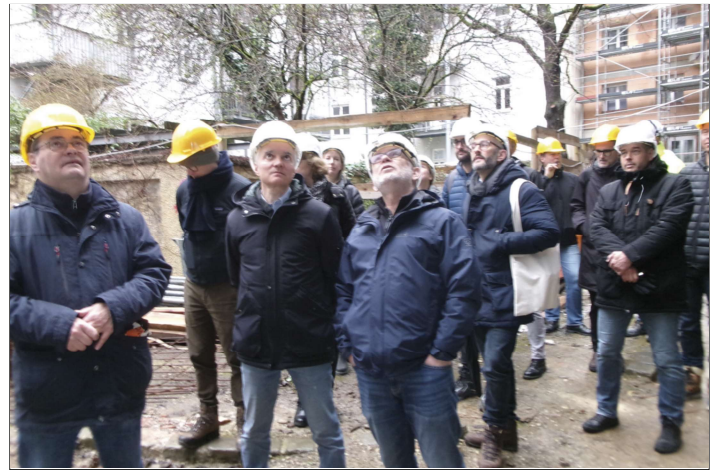
Vorstand und Aufsichtsrat bei einer prüfenden Begehung der Baustelle Ende März Foto: cws
