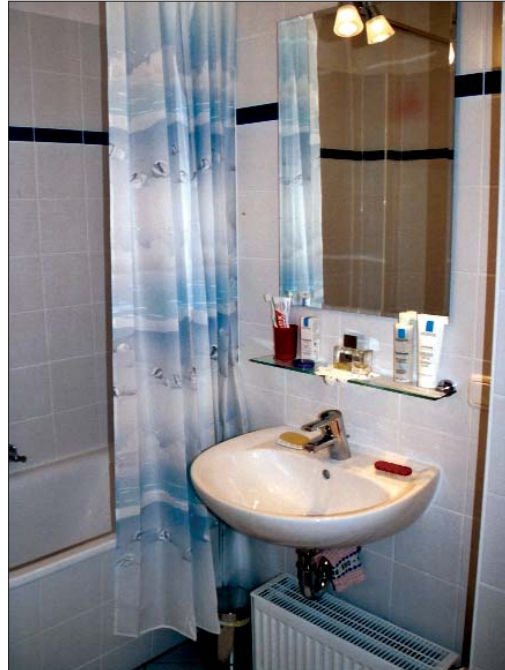
Das neue Bad in modernem Standard – ein Grund mehr, sich nach überstandenem Umbau im Haus Rossinistr. 1 so richtig wohl zu fühlen. F.: cws
