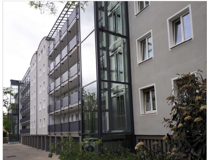
Die leichte Konstruktion der zwei Aufzüge aus Stahl und Glas harmonisiert hervorragend mit den ruhigen Grautönen der Fassade. Sein Baujahr 1962 sieht man dem Haus nicht mehr an.
