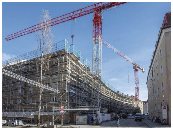
Die Baustelle in Haidhausen: Blick von der Grillparzer- in die Hackländerstraße. Die Sanierung ist auf einem guten Weg.
